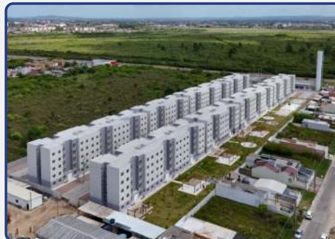
Jardim das Magnólias Pelotas – Obras adiantadas
