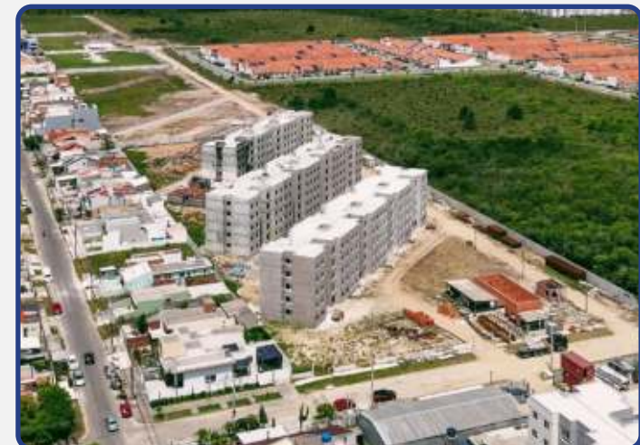
Jardim dos Jacarandás Pelotas – Obras adiantadas
