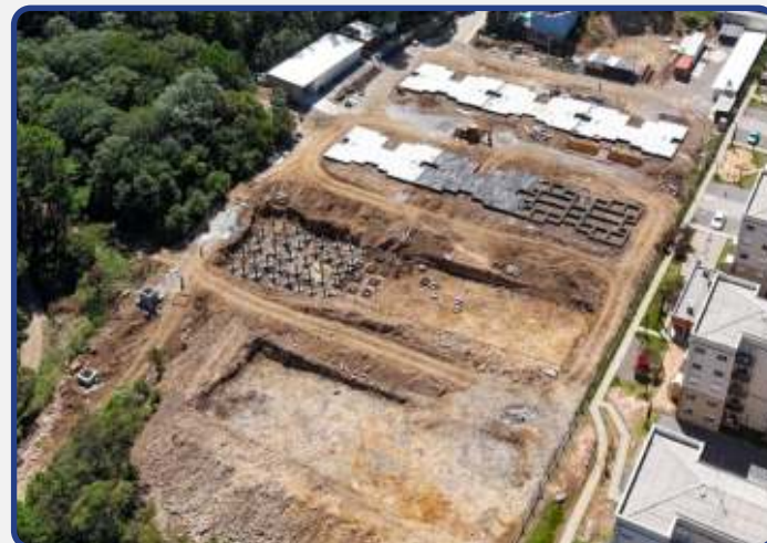
Residencial Belluno Caxias do Sul – Obras adiantadas
